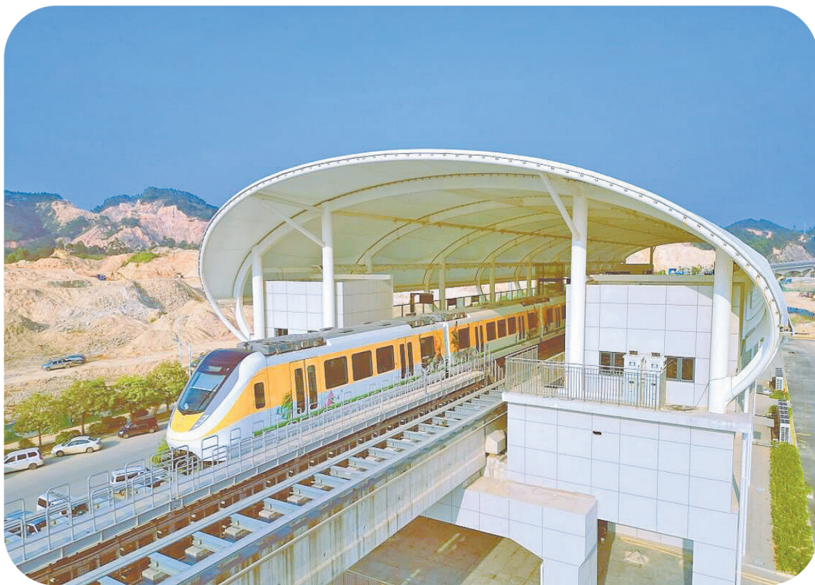
12月15日,中铁十一局电务公司参建的国内首条中低速磁浮旅游专线——清远磁浮工程全线供电系统送电成功。该工程全长8.1公里,设计时速100公里,开通后将实现广清城际银盏站与清远长隆景区联通,为游客旅行和沿线市民出行提供便利。图为空载试运行的清远磁浮列车。黄松河摄
