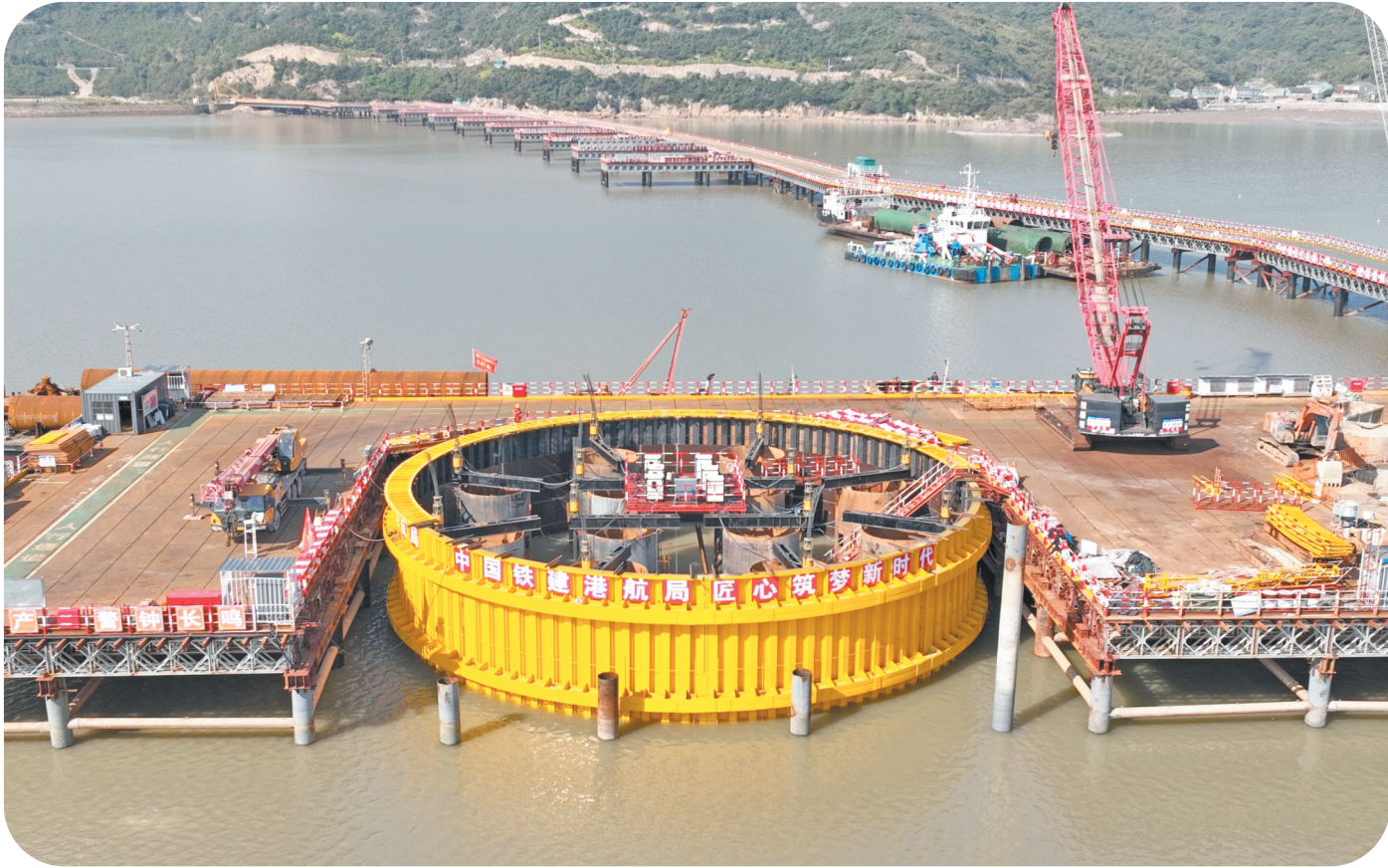
11月19日,由中国铁建大桥局、中国铁建港航局联合体承建的世界最大跨度单跨吊钢箱梁悬索桥——双屿门大桥佛渡侧索塔主墩钢围堰顺利下放,标志着大桥正式进入海上主塔承台施工阶段。该桥是宁波舟山港六横公路大桥二期关键控制性工程,也是我国跨度最大的跨海桥梁,主跨1768米,连接六横岛与佛渡岛两座独立海岛。图为大桥佛渡侧索塔主墩钢围堰下放。
