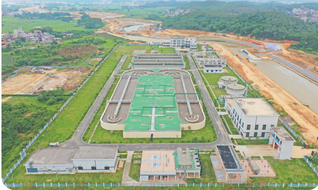
中铁二十局建设运营的广东省廉江市水质净化厂是广东省一项重要民生工程。配套管网总长75公里的水厂,覆盖廉江市区及17个城镇、2个工业园区,对改善廉江水环境、提高人民群众生活质量具有重要作用。该水质净化厂自2020年9月试运行以来,累计净化污水超1亿吨,相当于7个杭州西湖的容量。 陶柯宇 摄
