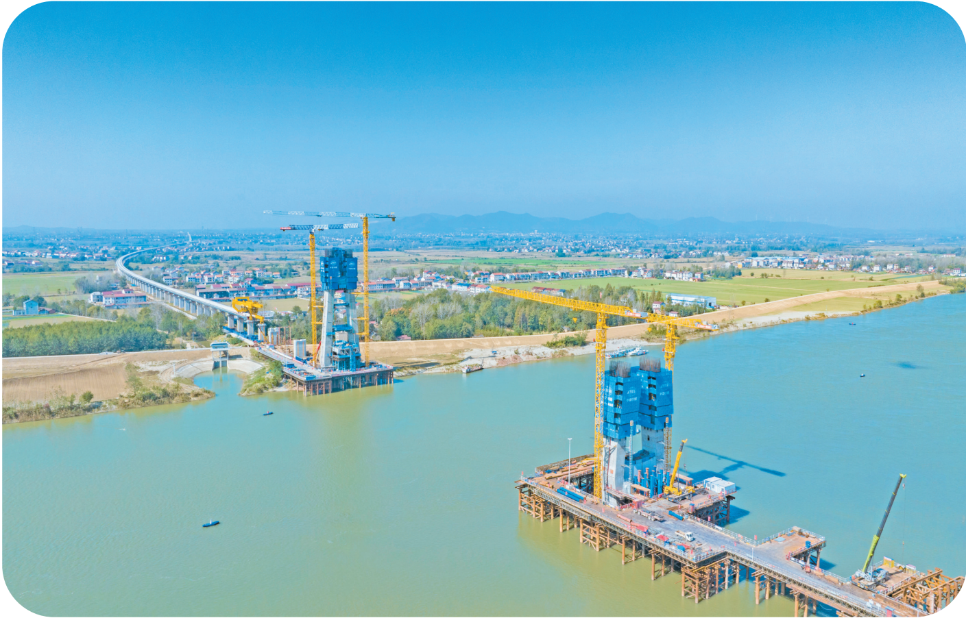
10月28日,由中铁十一局承建的沪渝蓉高铁钟祥汉江特大桥首组斜拉索顺利挂设。该特大桥主桥长547.5米,主跨270米,设64对斜拉索,是我国跨度最大的高速铁路无砟轨道混凝土梁斜拉桥。图为正在进行斜拉索施工的钟祥汉江特大桥。 金 伟 摄
