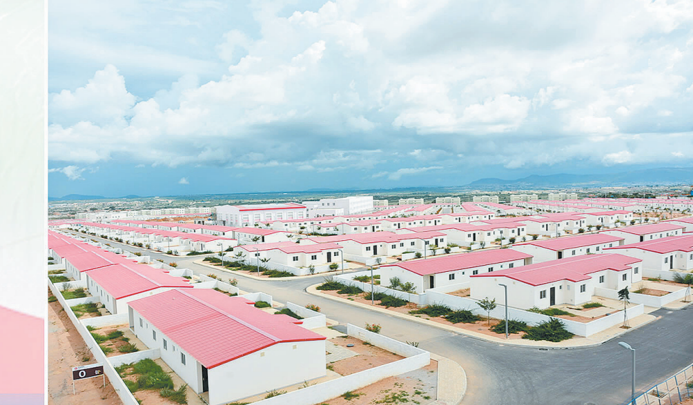
▲中铁十七局承建的安哥拉民生民生工程RED卢班戈一期13栋项目住房工程顺利交付,2000余户当地居民喜迁新居,切实感受到“中国建造”带来的新变化。王秀秀摄
