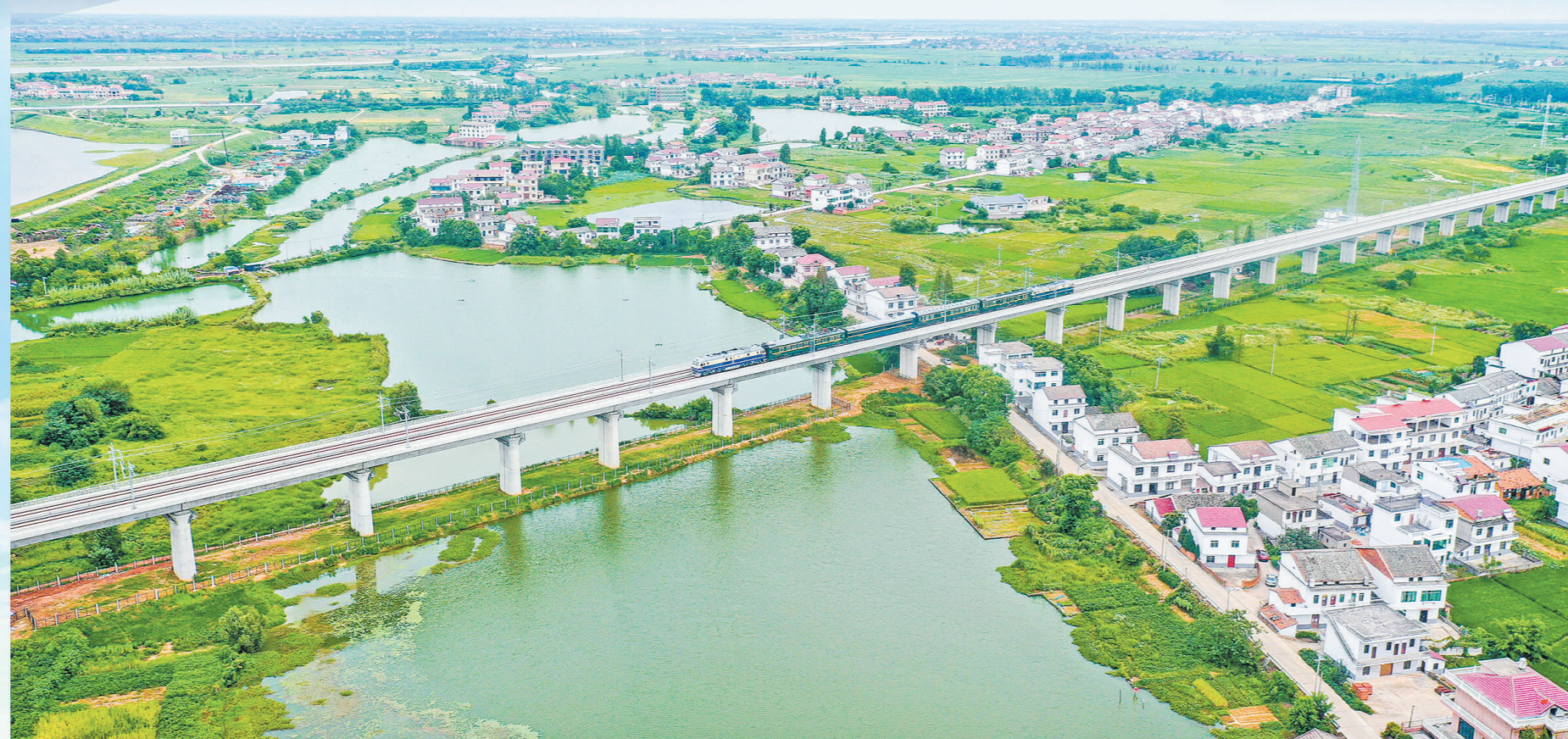
▲8月25日,由中国铁建大桥局、中铁十四局、中铁十七局、中铁十八局、中铁二十五局、中铁建电气化局等单位参建的(南)昌景黄(德镇)黄(山)高铁全线正式开始联调联试。昌景黄高铁将沿线婺源德镇、鄱阳湖和黄山风景区等多个国家级旅游景区串联起来,形成一条跨越名城、名镇、名湖、名山的世界级黄金旅游线。苏冬摄
