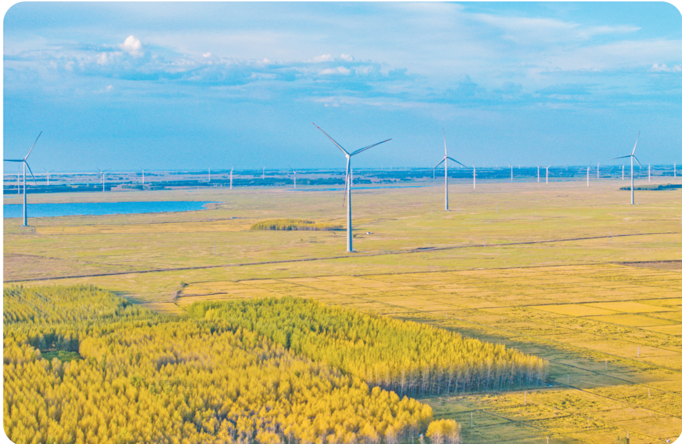
9月18日，由中铁十五局承建的齐齐哈爾龍江300兆瓦風電項目最後一台風機混塔開始吊裝。該項目是黑龍江省重點工程，也是中國鐵建在內陸裝機容量最大的風電總承包項目。該項目并網完工後，年均發電量可達83370萬千瓦時，減少二氧化碳排放量70.06萬噸。因為該項目已經吊裝建設完成的混塔風機。 丁怡然 攝
