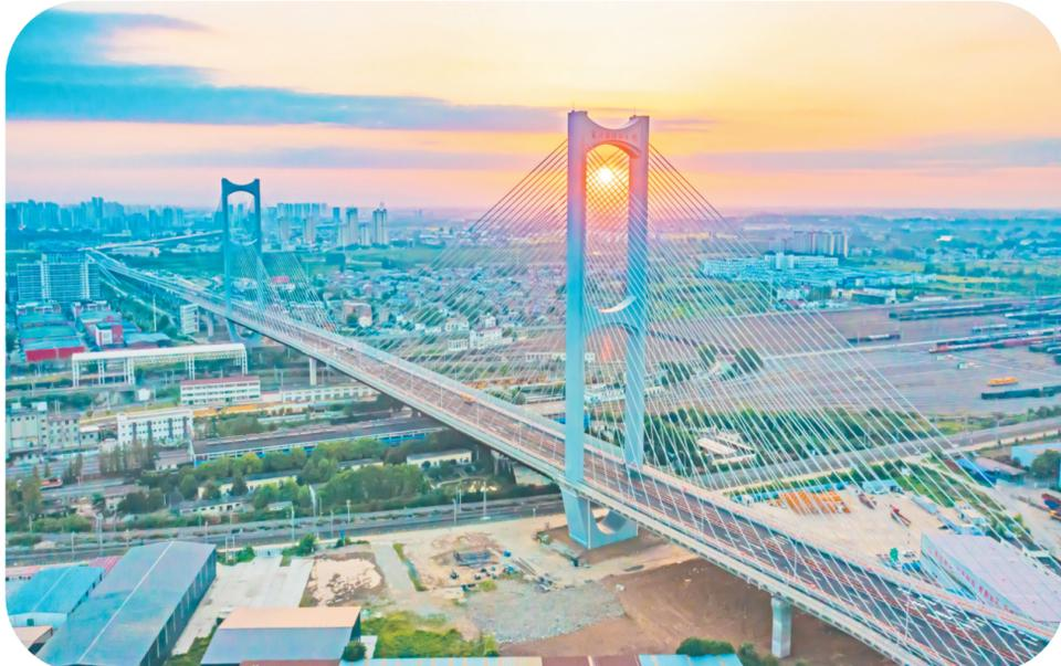
9月11日,由中铁十一局承建的襄北编组站大桥顺利通车,标志着襄阳市环线提速改造一期工程正式通车,该工程全长15.28公里。襄北编组站大桥为双塔双索面混合梁斜拉桥,主桥长920米,宽37.5米,主跨520米,跨越32股铁路线,是世界首座齿轮齿轨式转体斜拉桥。该项目建成通车后,对构建襄阳半小时市区通勤圈,优化“一心四城”空间格局具有重要意义。图为建成后的襄北编组站大桥。 古建敦 摄
