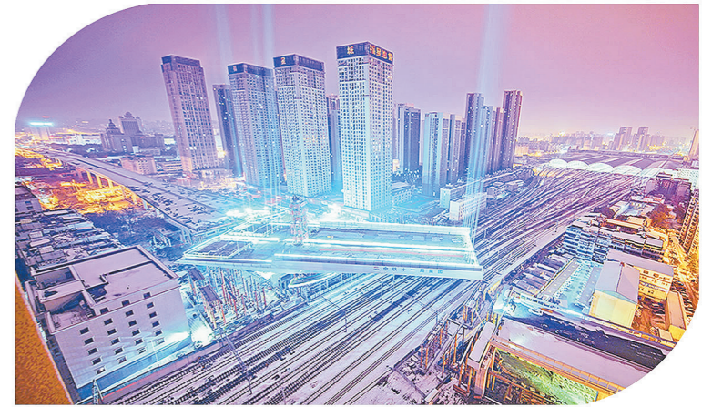
汉江重工制造安装的8800吨全国首个极不平衡钢箱梁在武汉常青路顺利转体创下三项世界纪录
