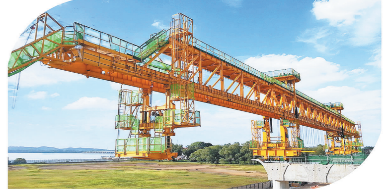
汉江重工自主研发的亚洲首台480吨节段拼装架桥机在新加坡大士西延长线投入使用
