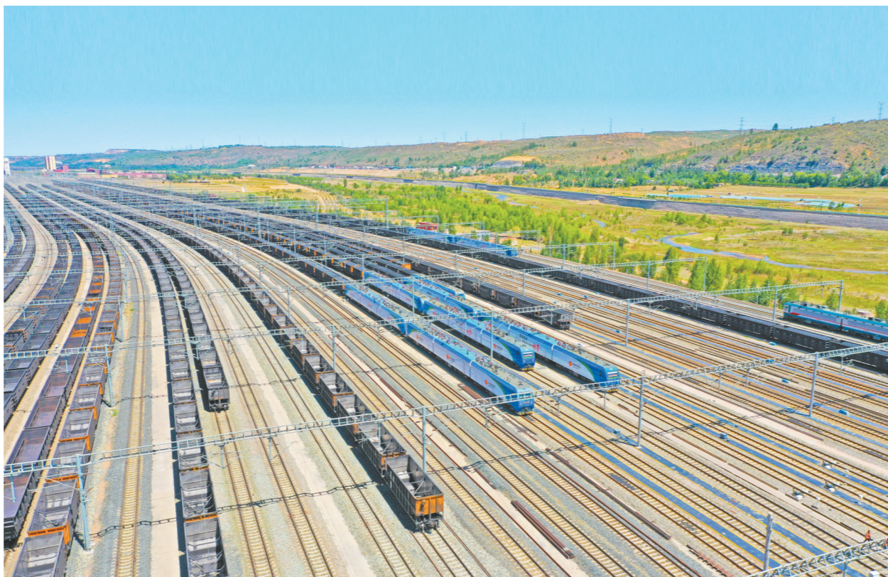
在我国西部最大的煤炭运输编组站——神朔铁路朱盖塔站,中铁十六局铁运公司朱盖塔车辆检修项目部精修细修,严格执行一班一列一车作业标准,加强货车“七防”,有效提升了货车检修质量,确保铁路行车安全。截至9月5日,该项目部顺利完成年度车辆检修21921列、1244914辆,保障安全运输煤炭总量超过9300万吨,有力发挥了能源供应压舱石作用。图为神朔铁路朱盖塔站检修作业现场全景。王成成 摄
