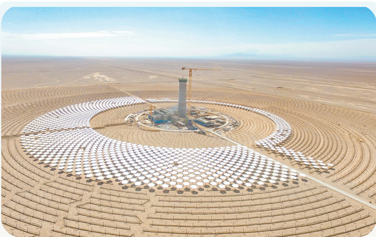
8月27日,由中铁十一局承建的阿克塞江新能源光热+光伏试点项目厂前区主体结构顺利封顶。该项目位于甘肃省酒泉市,最高海拔3600米,总建设用面积约16平方公里。项目建成后,可实现年上网电量17亿千瓦时,对加快构建当地新能源增长极、谱写中国式现代化甘肃实践新篇章具有积极意义。图为建设中的光热动力岛区及镜场区。杨欣欣 摄
