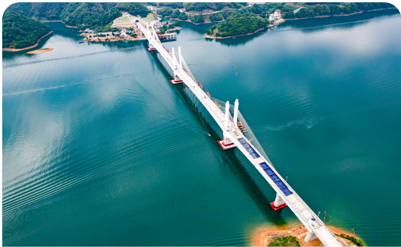
由中国铁建大桥局施工的池黄高铁太平湖特大桥是国内高速铁路最大跨度多塔矮塔斜拉桥,位于国家5A级景区名胜区黄山太平湖风景区内,大桥全长926.1米,横跨太平湖面。施工中,项目团队精细搭建钢便桥快速施工,采用泥
