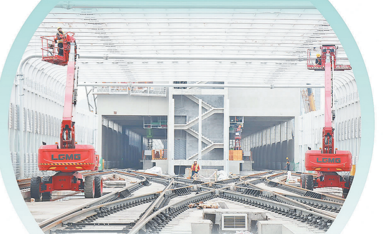
利用曲臂车安装声屏障挡板
