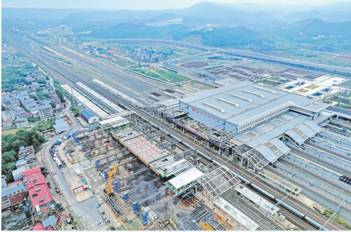
5月24日,由铁五院设计、中铁建设承建的安九高铁全线最大车站,庐山站东站房完成首次顶推,标志着世界首例大型站改钢结构跨线首次顶推顺利完成。该站房建筑面积6万平方米,车场规模8台25线。此次顶推一举创造了站房改造工程跨线顶推施工中宽度、重量、面积、滑轨数量4项世界纪录。施工中,项目部创新采用空间限位转换等技术,攻克了站房大体量钢结构组合体上跨多条不停车轨道顶推及复杂钢结构体过程中易变形、难控制等施工难题。图为城际列车通过顶推成功的庐山站东站房。王舒摄
