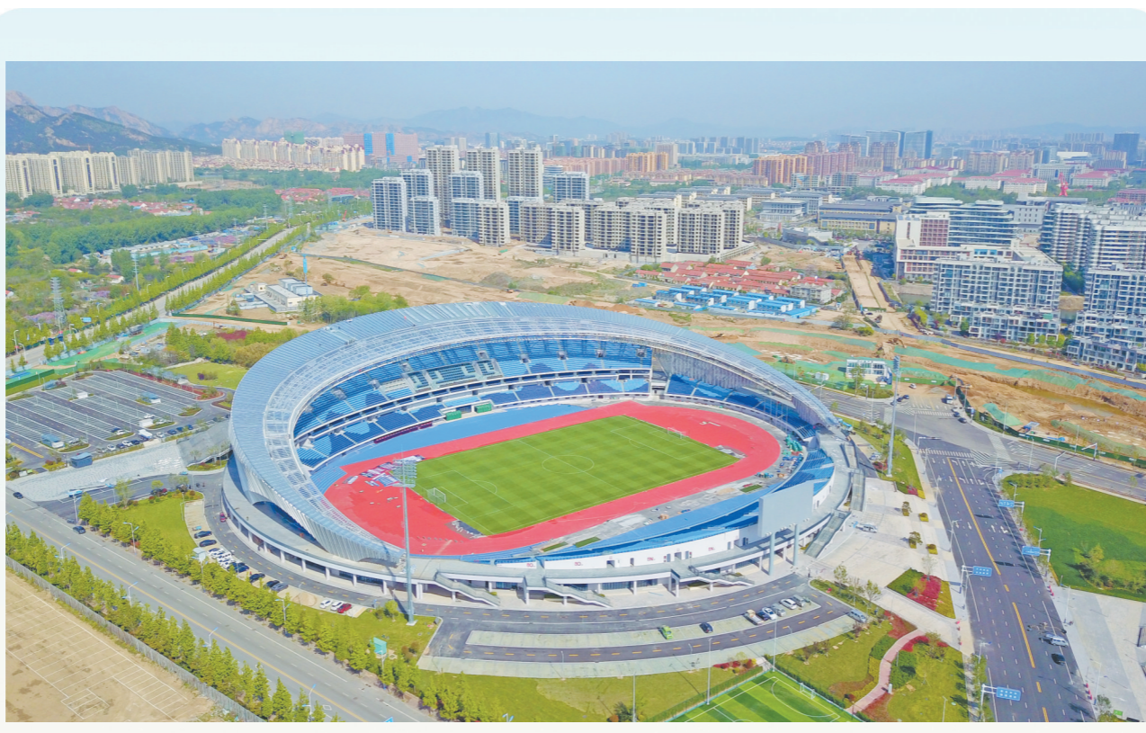
5月10日,由中铁建设承建的青岛西海岸新区古镇口体育场迎来建成首秀,中国足球协会甲级联赛青岛西海岸队在此主场迎战黑龙江冰球队。古镇口体育场建筑面积4.2万平方米,现场可容纳2万名观众,从空中看造型如同一枚贝壳。施工中,项目团队通过优化铸钢节点、悬挑长度,采用“地面拼装、单元提升”以及整体同步交替分级卸载的方案,顺利攻克大跨度钢结构吊装等施工难题。图为古镇口体育场全景。 郝友鑫 摄
