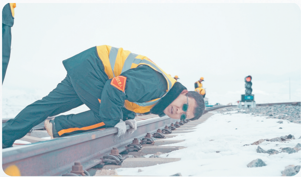
图为高钱胜现场检查线路病害。
