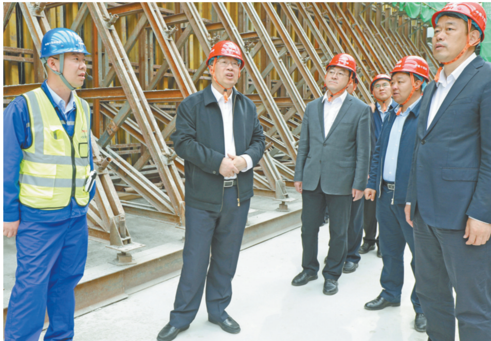
图为4月28日,庄尚标(左二)在北京轨道交通13号线扩能提升工程后厂村站现场检查。范少文摄
