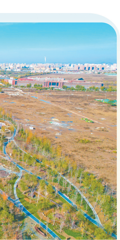
2月22日,中铁十六局一公司保定市环城大水系项目建设者正在向项目竣工验收发起最后冲刺。施工中,项目建设者秉承“治水”与“治城”相结合的理念,通过河底清淤、河道疏通、两岸绿化提升、景观河道补水、堤防修建等方式,让流经白洋淀上游的8条河流实现了水更清、岸更宽、景更美,为高标准推进白洋淀上游流域综合治理,打造拱卫首都和雄安新区生态绿色屏障创造了有利条件。图为保定大水系建设项目南环堤河段航拍景象。
