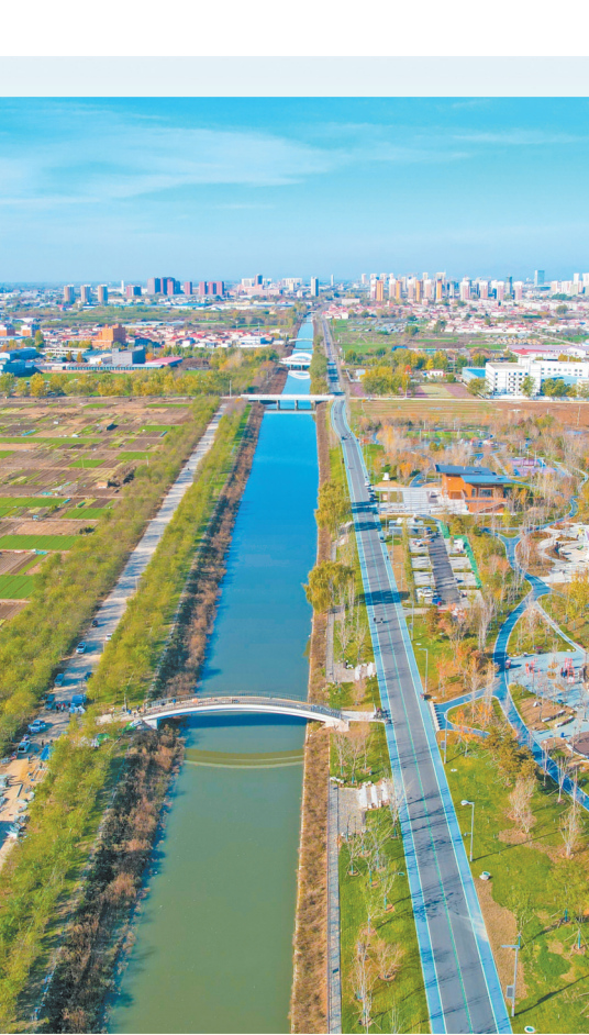
2月22日,中铁十六局一公司保定市环城大水系项目建设者正在向项目竣工验收发起最后冲刺。施工中,项目建设者秉承“治水”与“治城”相结合的理念,通过河底清淤、河道疏通、两岸绿化提升、景观河道补水、堤防修建等方式,让流经白洋淀上游的8条河流实现了水更清、岸更宽、景更美,为高标准推进白洋淀上游流域综合治理,打造拱卫首都和雄安新区生态绿色屏障创造了有利条件。图为保定大水系建设项目南环堤河段航拍景象。
