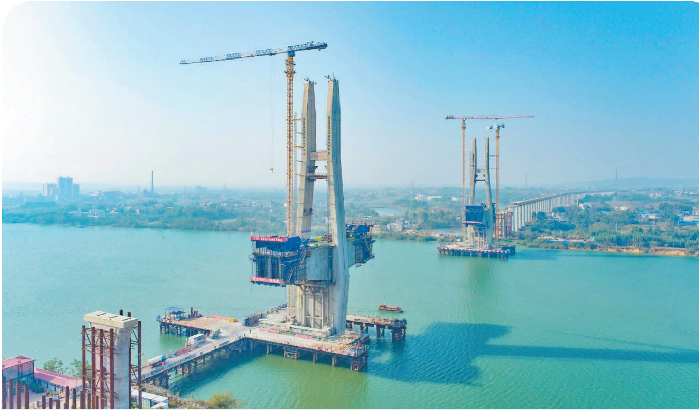
近日,由中铁十一局承建的新建南宁至玉林铁路六景江特大桥P4主塔6号梁段顺利浇筑,标志着世界施工总重量最大的“千吨级”高速铁路现浇梁段施工完成。南玉铁路六景江特大桥全长11.465公里,主桥为钢-混部分斜拉桥,主跨320米,此次浇筑的6号梁段施工总荷载达1340吨,是目前世界上时速350公里高速铁路现浇梁施工总重量最大的节段。施工中,建设者创新研发了世界首台“千吨级”悬臂造桥机,解决了大节段承重主梁受力大的难题,累计形成科研成果40余项,填补了多项技术空白,为大桥安全优质建设提供了科技保障。图为建设中的南玉铁路六景江特大桥。 王占辉 摄
