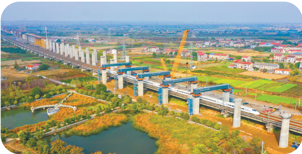
2022年11月22日,由中铁十二局承建的新建湖北荆(门)荆(州)高铁江汉运河2号特大桥5处跨(武)汉宜(昌)铁路钢盖梁施工全部完成,标志着全线“咽喉要道”成功打通,为后续架梁、铺轨施工创造有利条件。荆荆高铁全长约77公里,设计时速350公里,是我国“八纵八横”高速铁路网中呼(和浩特)南(宁)高铁双通道的重要组成部分。图为高速列车经过完成吊装后的钢盖梁。徐云华 摄
