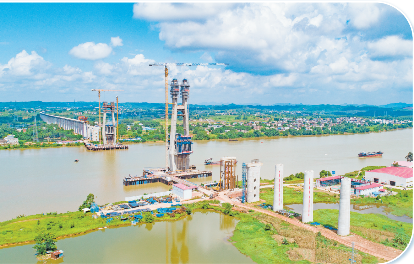
中铁十一局在新建南宁至玉林铁路(简称南玉铁路)施工中，积极开展科技攻关，先后攻克了裸岩地质条件下栈桥施工、大直径深水桩基成孔、水下爆破快速清基等施工难题，累计形成科研成果40余项，有力推进了施工进度。图为国内高速铁路最大跨度的钢混部分斜拉桥——南玉铁路六景都江特大桥目前正在加紧建设。
