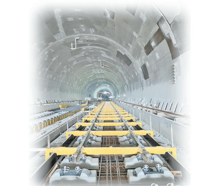
福厦铁路南靖隧道正在进行洞内无砟轨道施工
