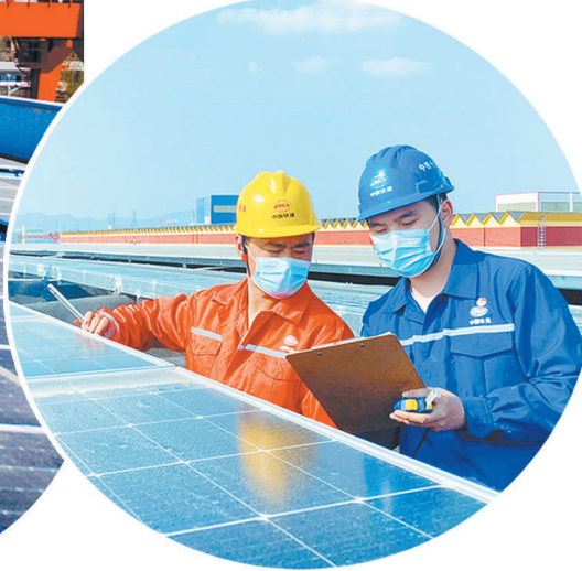
图为技术人员对光伏面板进行检查。
