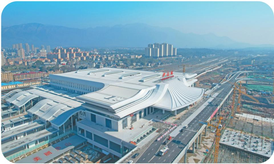
3月22日,由中铁建设承建的庐山站改造工程全新亮相。升级后的庐山站建筑面积6万平方米,车场规模8台25线,是安九铁路全线最大高铁站房。建设过程中,项目团队采用曲面空间三维精准定位法,打造了国内首例“高落差瀑布式大型曲面外墙幕”,再现了“飞流直下三千尺”的视觉效果。张森森 摄
