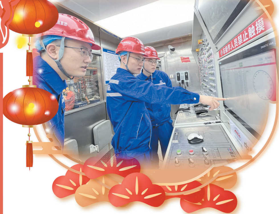
春节期间,中铁十四局北京东六环改造工程项目留守职工孙旭涛及孙长松指导王虎然设置并控制盾构机施工参数。 宗 悦 摄
