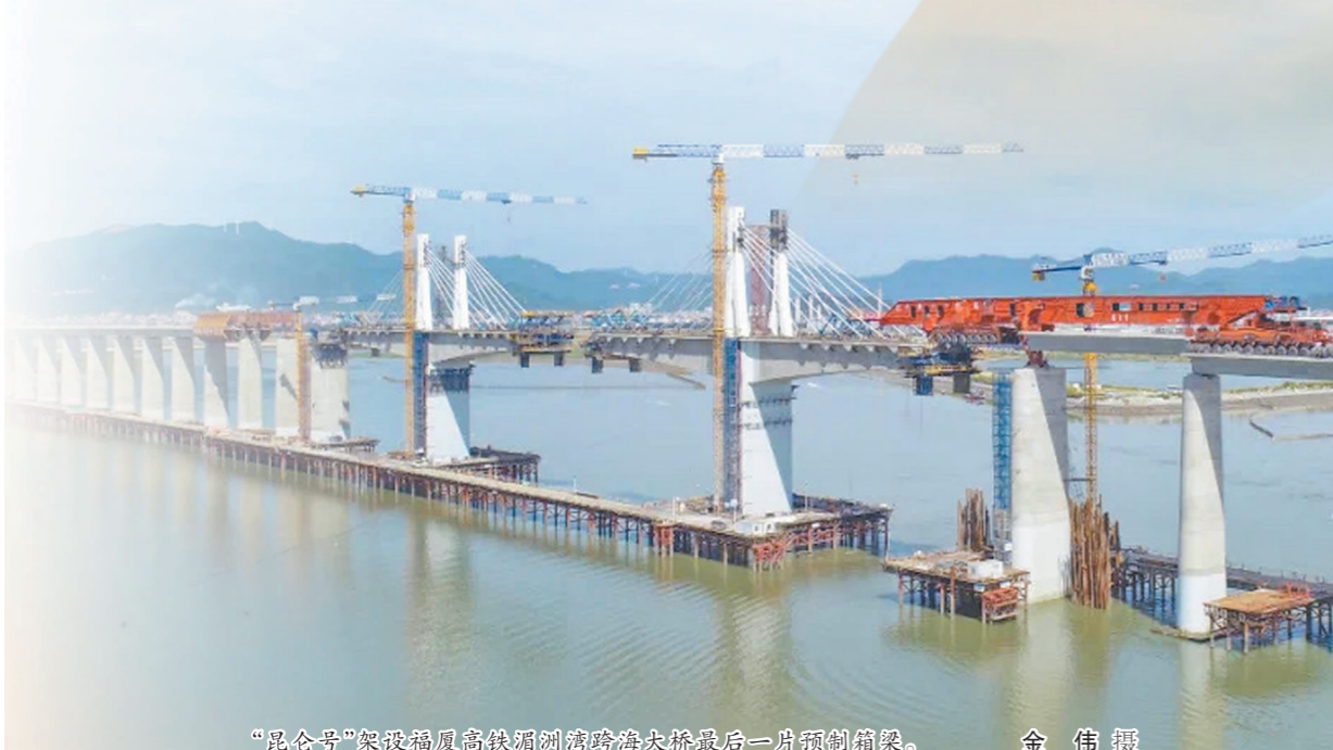
“昆仑号”架设福凤高铁朔州湾跨海大桥最后一块预制箱梁。 金 伟 摄
