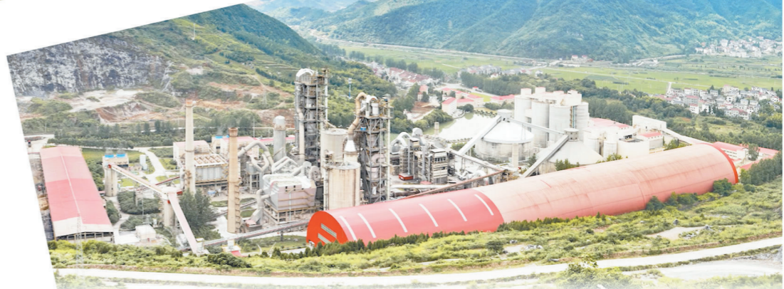
浙江建德海螺项目
