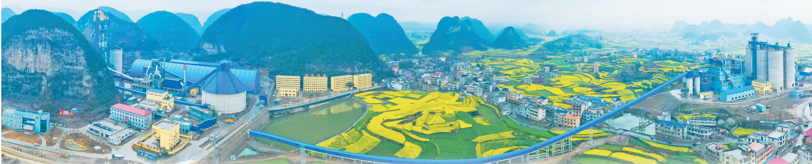
华润水泥(安顺)日产4500吨熟料新型干法水泥生产线
