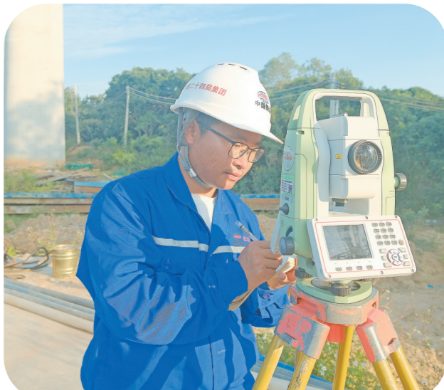
刘祥华在工地进行测量作业。伍宏俤 摄
