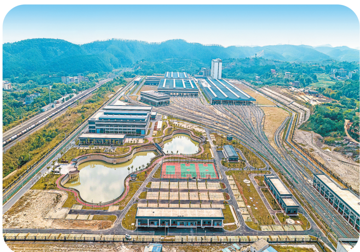
近日,由铁一院总体总包设计,中铁十八局、中铁二十一局参建的我国首个采用生态智能场段设计的车辆基地——南宁地铁5号线洪车车辆基地正式投入使用。该基地集智能运维、海绵城市、民族特色厂房、装配式综合管廊于一体,具备地铁列车检修、保养和清洁功能,同时也是抢险救援、物资存储的关键场所,是名副其实的地铁列车“4S店”,对推动城市轨道交通向智能化、生态化发展具有重要示范意义。图为洪车基地全貌。丁洋摄
