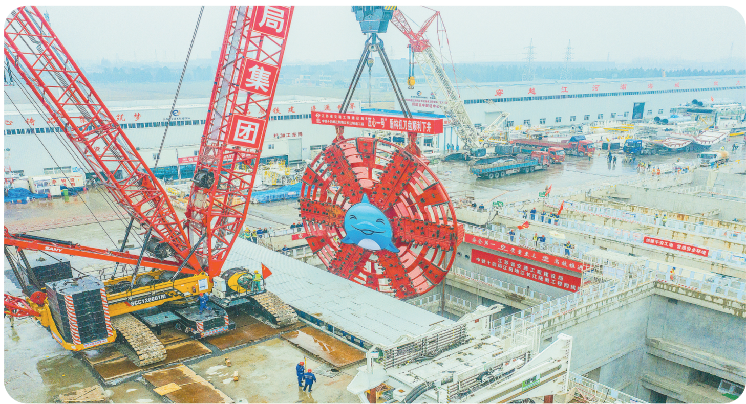
12月12日,由中铁十四局参建的长江流域最大直径盾构隧道——江阴靖江长江隧道盾构机“匠心一号”刀盘顺利吊装下井。刀盘下井定位安装后,将进行盾构机管线路连接、调试等工作,不久后将开启穿越长江之旅。该工程对落实长江经济带发展、长三角一体化国家战略,补齐过江通道短板,加快构建江苏省综合交通运输体系等具有十分重要的意义。
