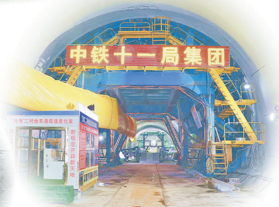
自主研发的隧道二衬信息化浇筑系统
