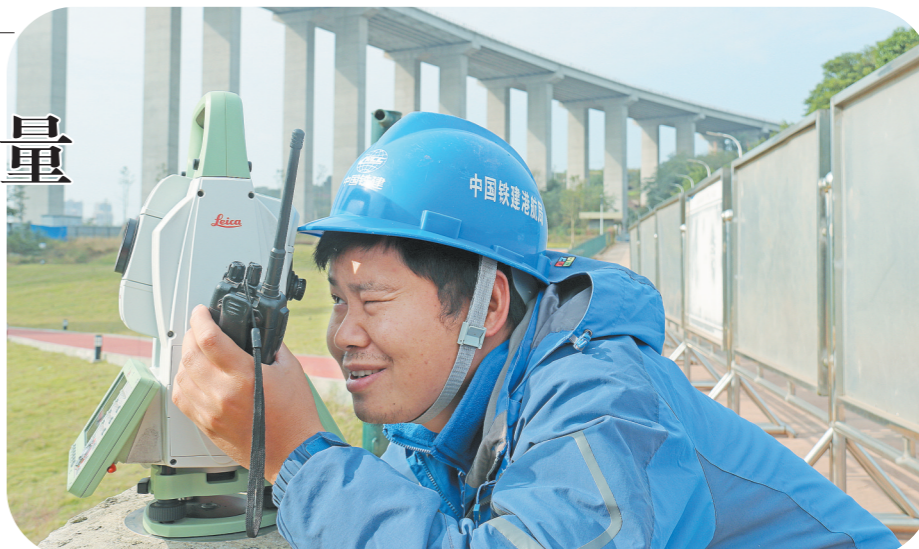
陈春霖正在东升大桥进行测量作业。
