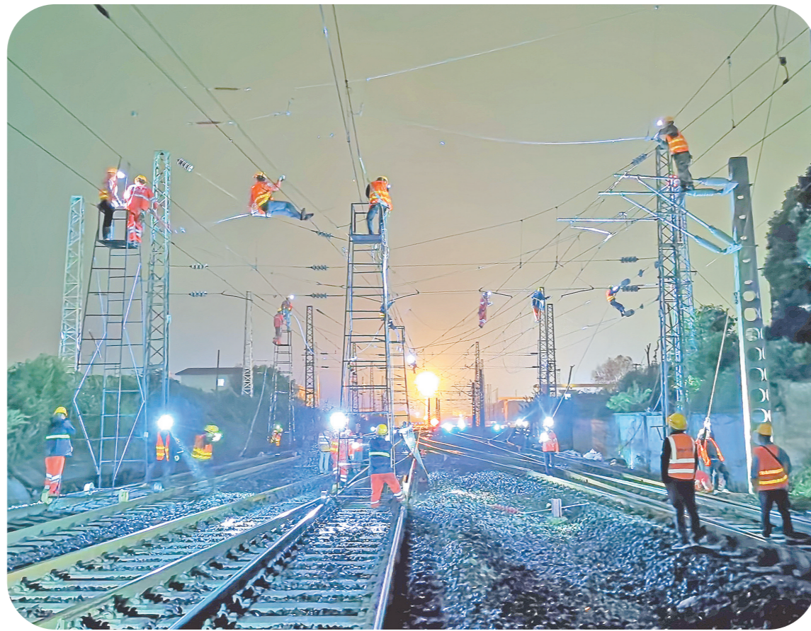
12月6日0时40分,随着湖潮火车站调度一声令下,由中铁十七局四公司负责施工的湖潮项目接触网改造工程进入攻坚阶段。此次封锁点施工,接触网软横跨跨越沪昆线3条股道,有效施工时间短,施工难度和安全压力高。该项目施工前多次进行模拟演练,施工中相关人员全程盯控指挥,保证施工顺利完成。王军 摄
