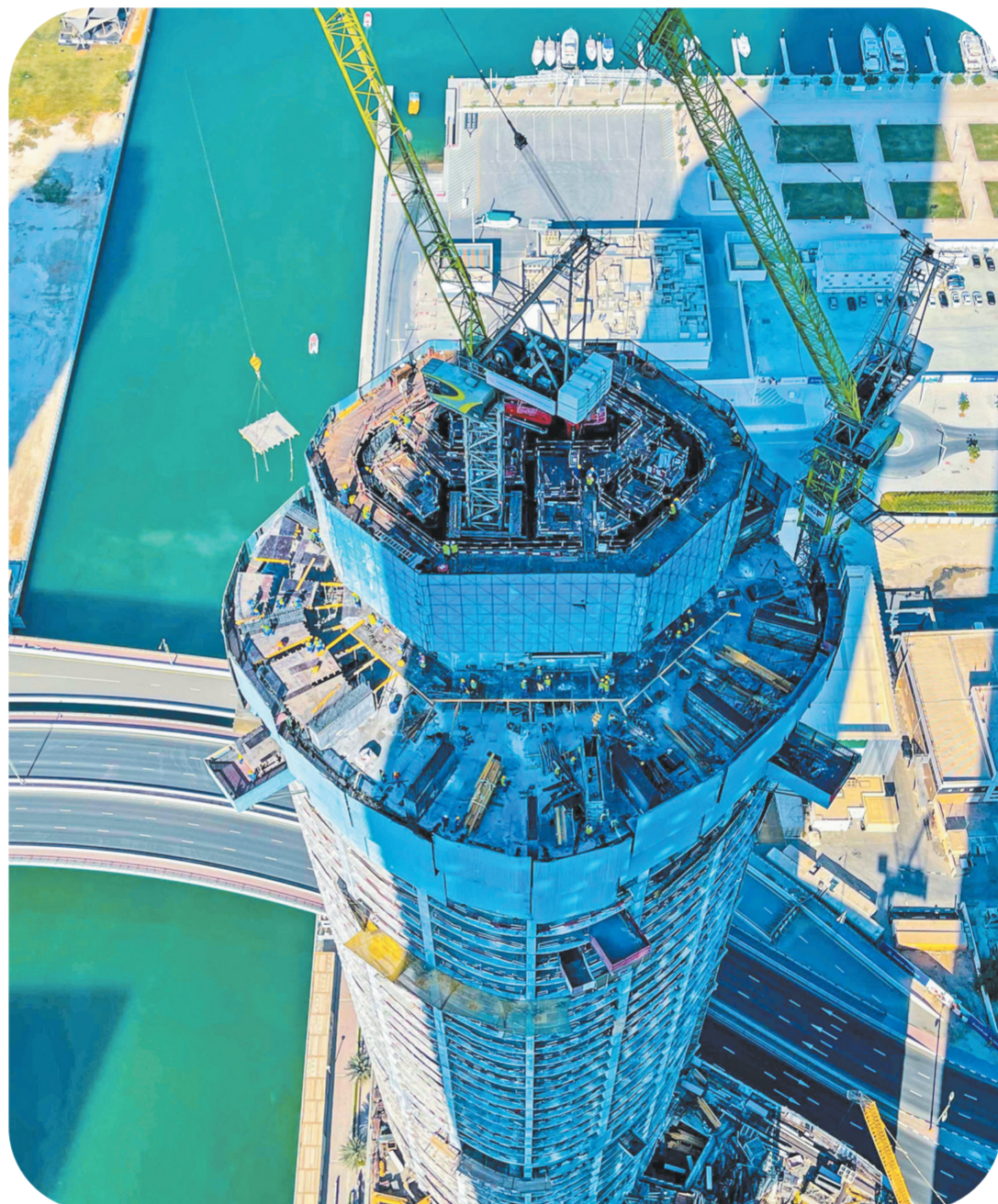
日前,由中铁十八局承建的全球最高酒店类建筑——迪拜蓝天酒店项目取得新突破。该工程设计建筑高度366.5米,施工中,项目团队精心组织,标准层施工进度从最初的6天一层,到实现3天一层,为完成全年目标任务打下坚实基础。图为项目正在进行核心筒施工。
