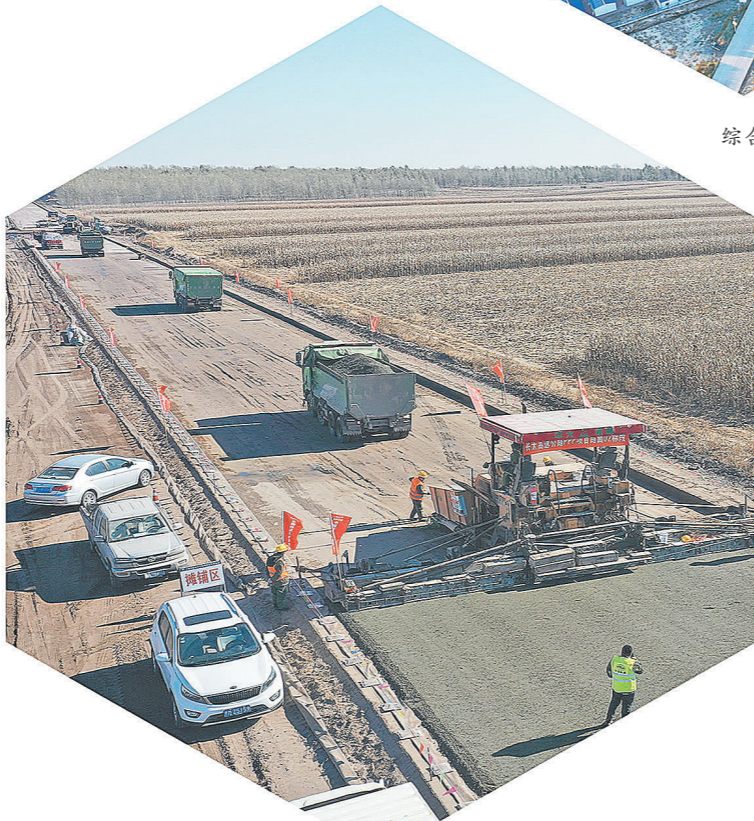
水稳摊铺施工现场
