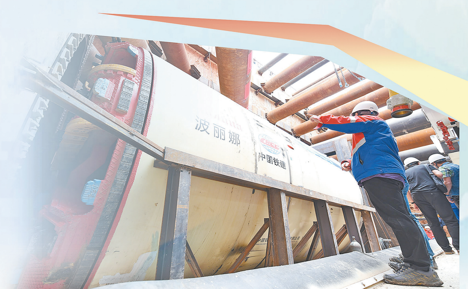
2018年6月11日,莫斯科地铁西南段项目首台盾构机“波丽娜”等在维尔纳工区成功始发,中国铁建自主研制的盾构机首次在莫斯科开始掘进。 吴少主 摄
