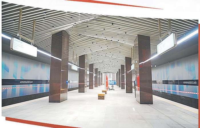
▲莫斯科地铁第三换乘环线西南段阿米尼站。 吴少主 摄
