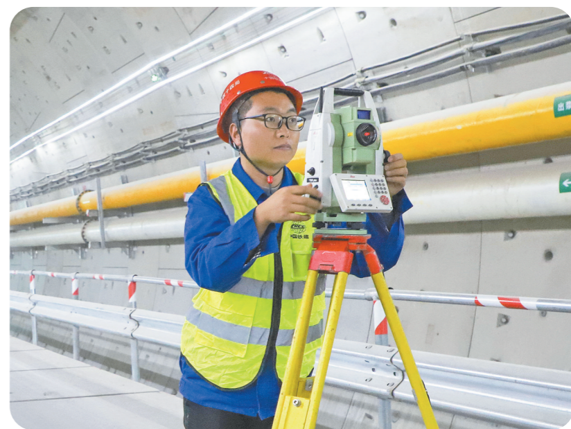
郑涛在隧道中进行盾构测量。 刘甲 摄
