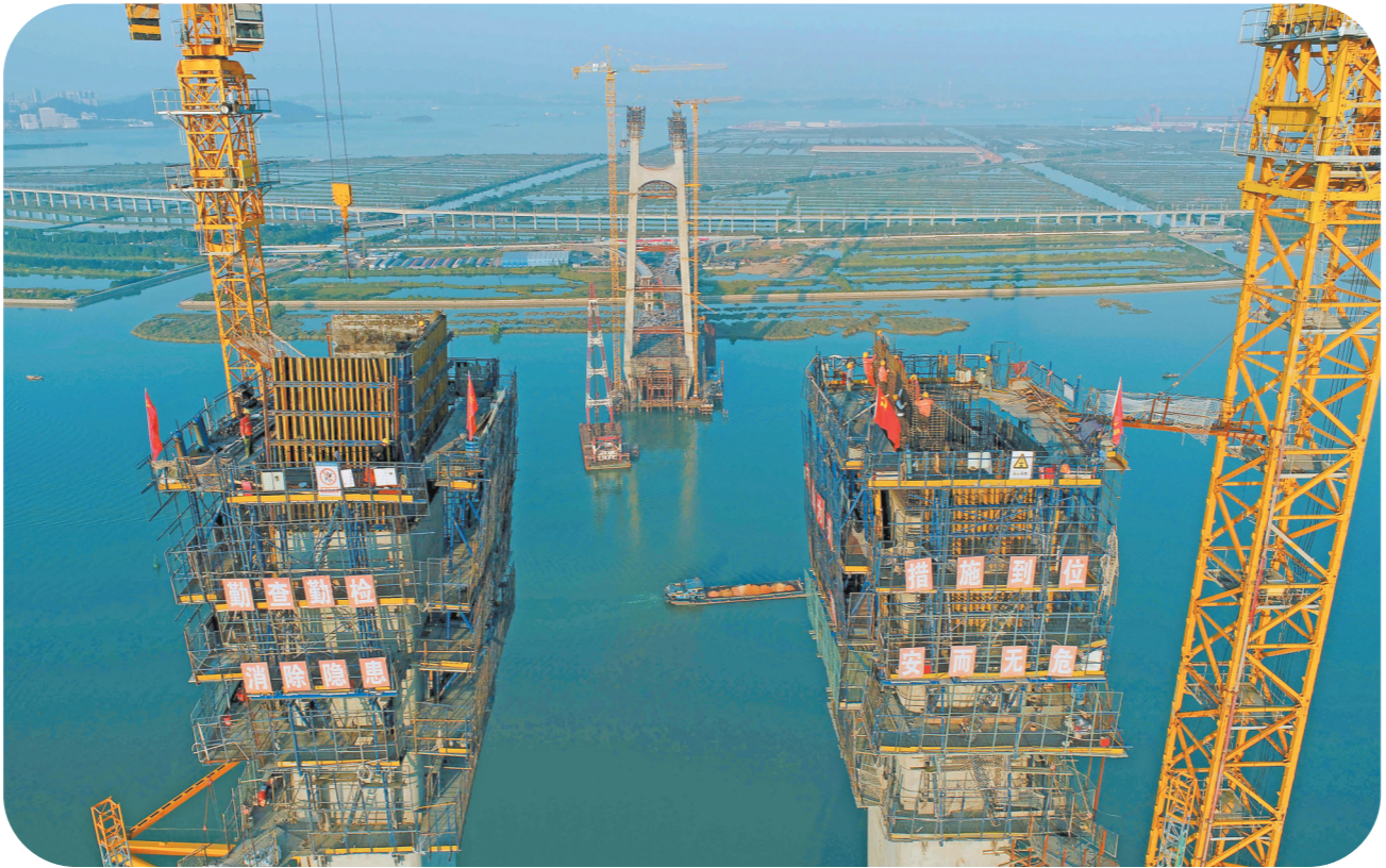
12月4日,由中铁十八局承建的广州南沙红莲大桥主塔顺利封顶,标志着大桥全面进入主桥钢箱梁安装阶段,为2022年建成通车创造了有利条件。该桥主桥长912米,采用双塔双索面混合梁斜拉桥型,塔高180米,飞跨珠江水系龙穴南水道的主桥跨度达580米,是目前我国同类型多功能斜拉桥的最大跨度。图为红莲大桥主塔封顶。 丁迪摄
