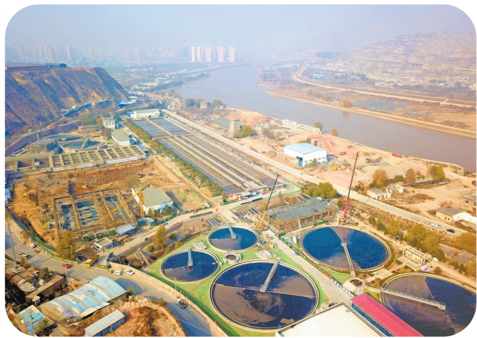
兰州市雁儿湾污水处理厂提标改扩建项目新系统工程。 权航摄
