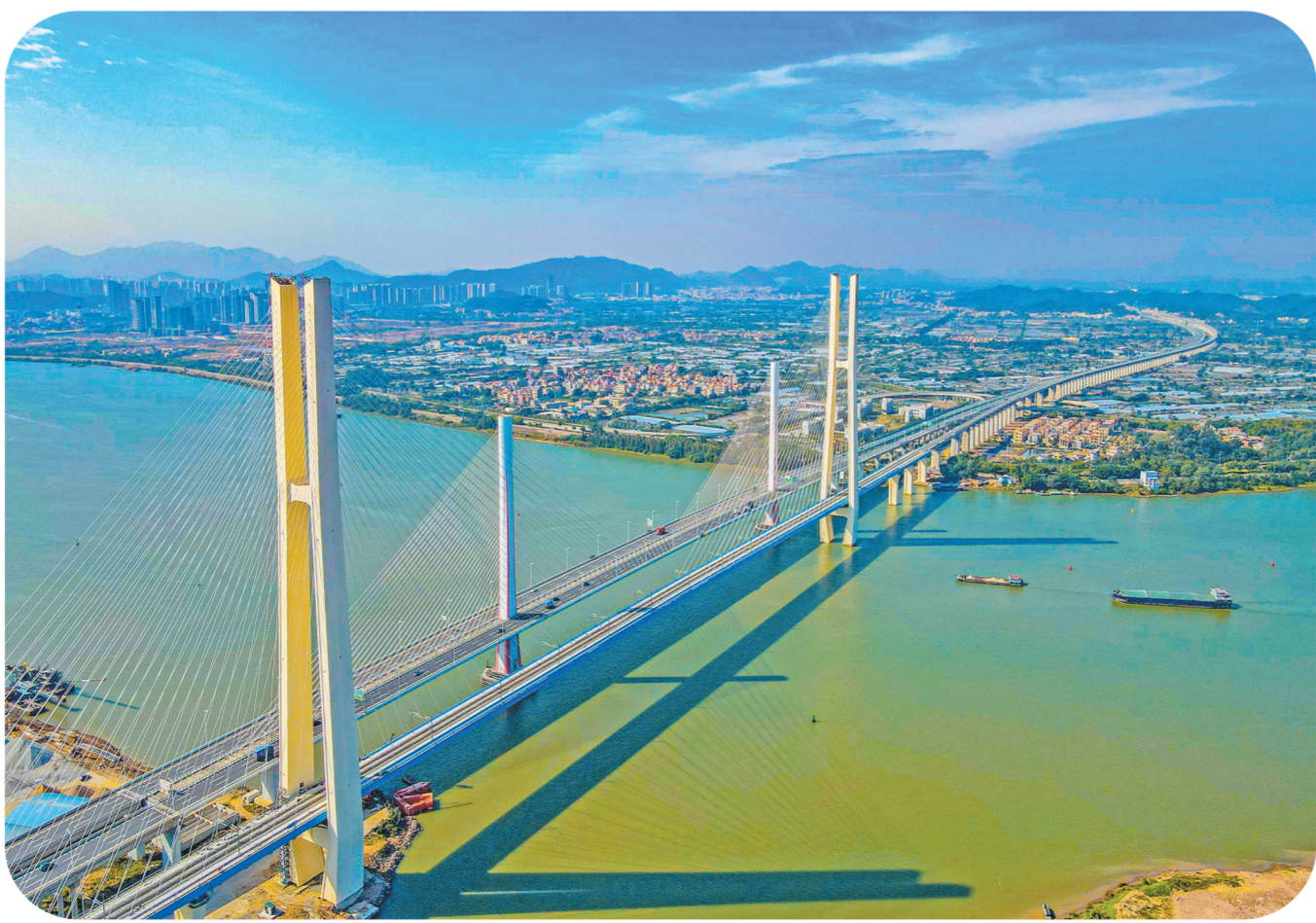
12月5日,由中铁十一局承建的粤港澳大湾区重点工程广州南沙港铁路跨西江斜拉桥二次调索完成,为年底建成达到开通条件奠定基础。该桥全长1117.5米,属钢箱混合双主梁结构,主跨跨径为600米,是目前世界上双线货运铁路建设史上同类型跨度最大的斜拉桥,通车后将实现地区物流运输革新,助力广州成为世界级铁路物流枢纽。图为调索完成后的广州南沙港铁路跨西江斜拉桥。 阙辉摄
