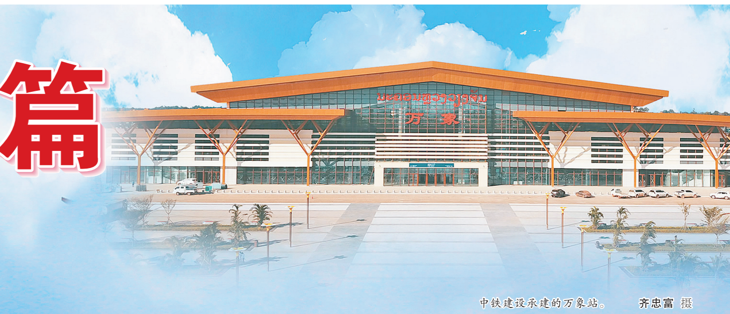
中老铁建承建的老万象站。 齐忠富 摄
