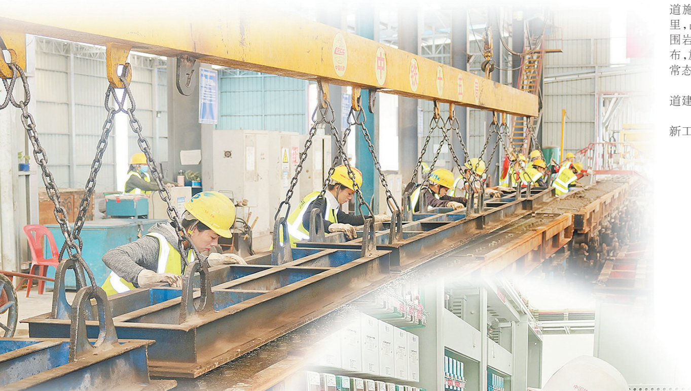
▲中老铁十五局老籍籍员工在轨枕生产的二道工序中检查直取芯棒。 李祖礼 摄
