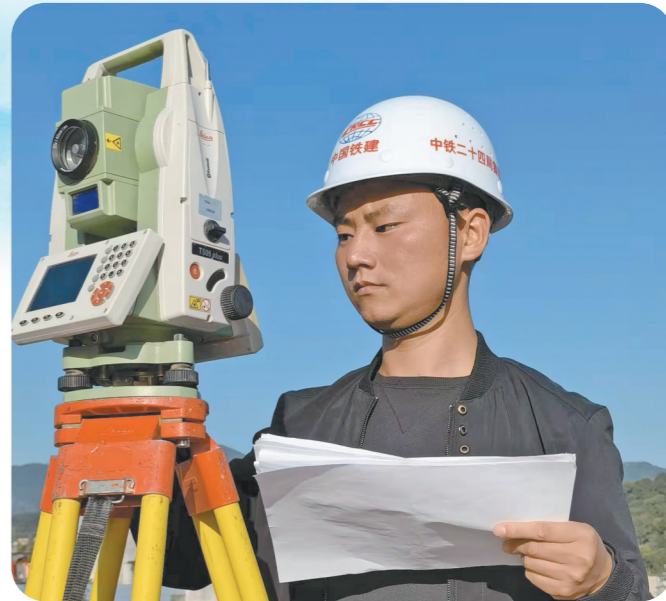
孟坤在工地测量。
