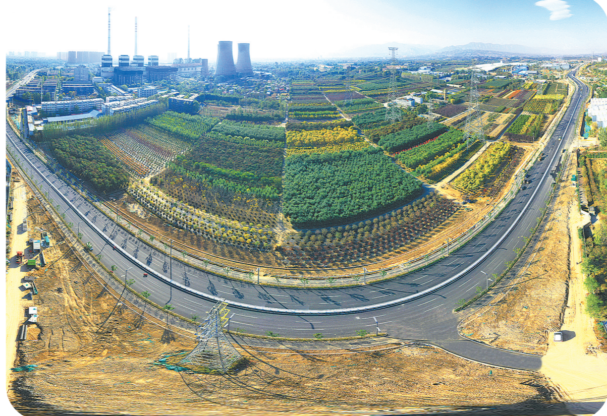
近日,由中铁十二局参建的大原北部出口新通道泥向线通车运营。泥向线是拉大城市发展空间,再现“锦绣太原城”盛景的重点市政道路工程,位于太原西北部,南起新兰路,北至黄东线,长约13.2公里。图为泥向线建设工程1标段。
