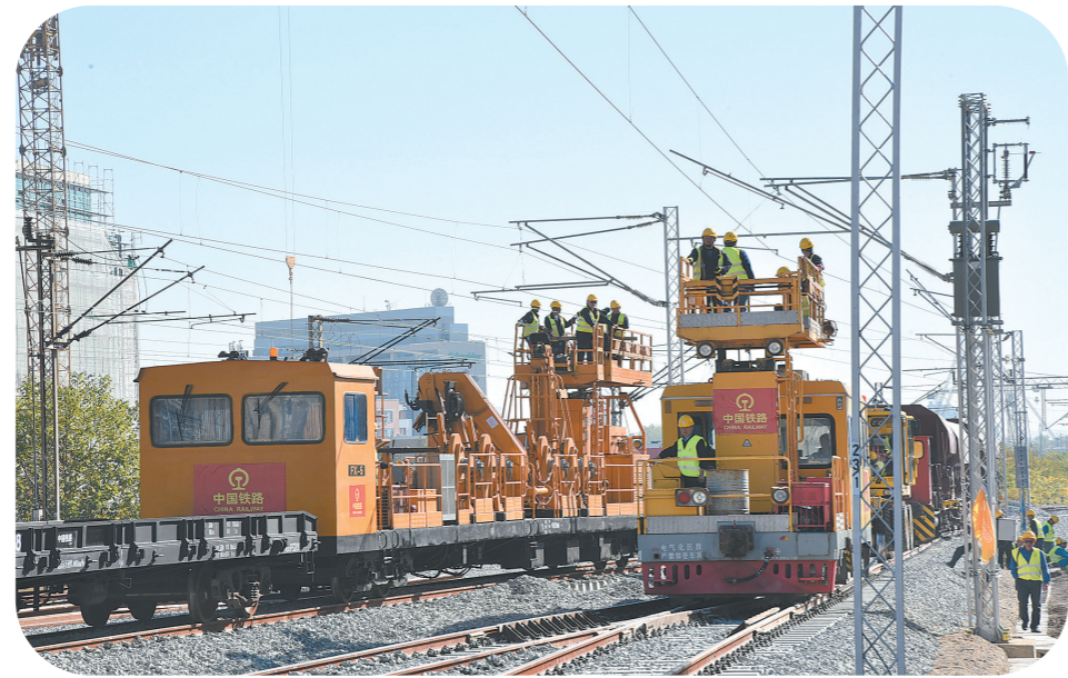
图为中铁建电气化局建设者在匈塞项目新贝尔格莱德站使用接触网轨道车进行施工作业。
