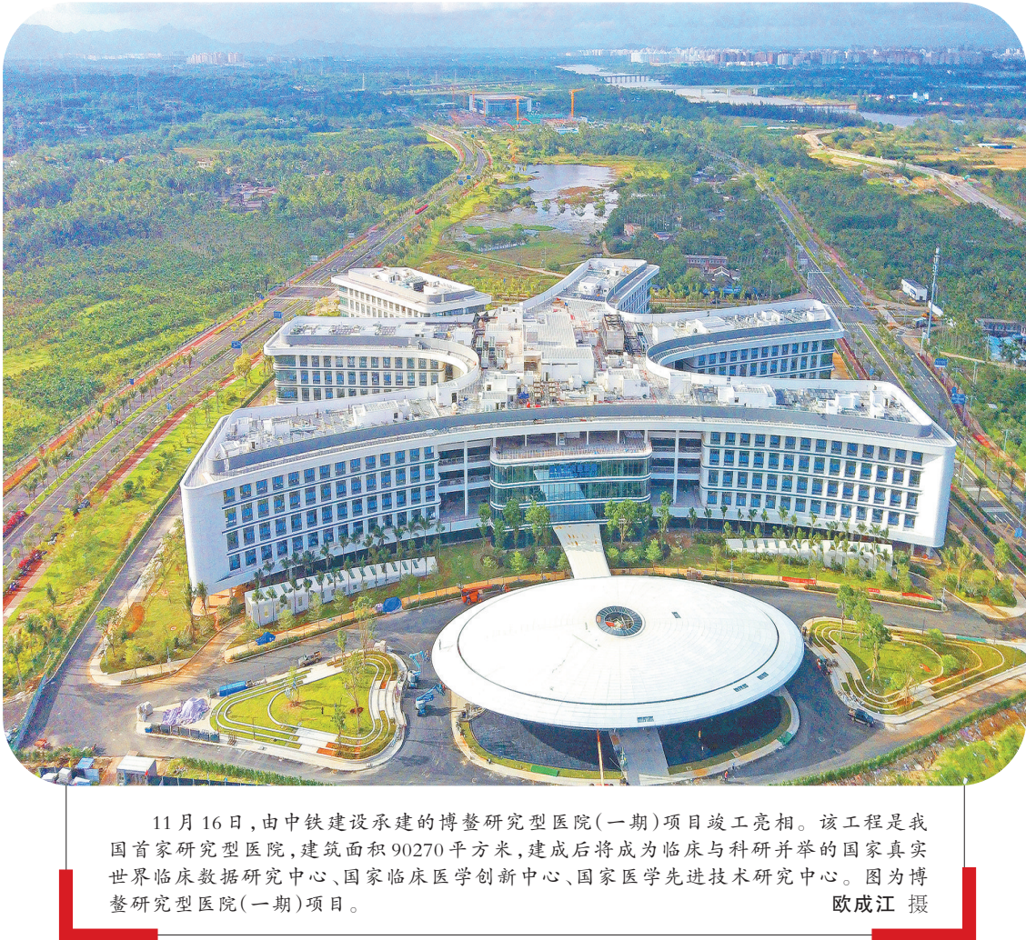
11月16日,由中铁建设承建的博整研究型医院(一期)项目竣工亮相。该工程是我国首家研究型医院,建筑面积90270平方米,建成后将成为临床与科研并举的国家真实世界临床数据研究中心、国家临床医学创新中心、国家医学先进技术研究中心。图为博整研究型医院(一期)项目。 欧成江 摄
