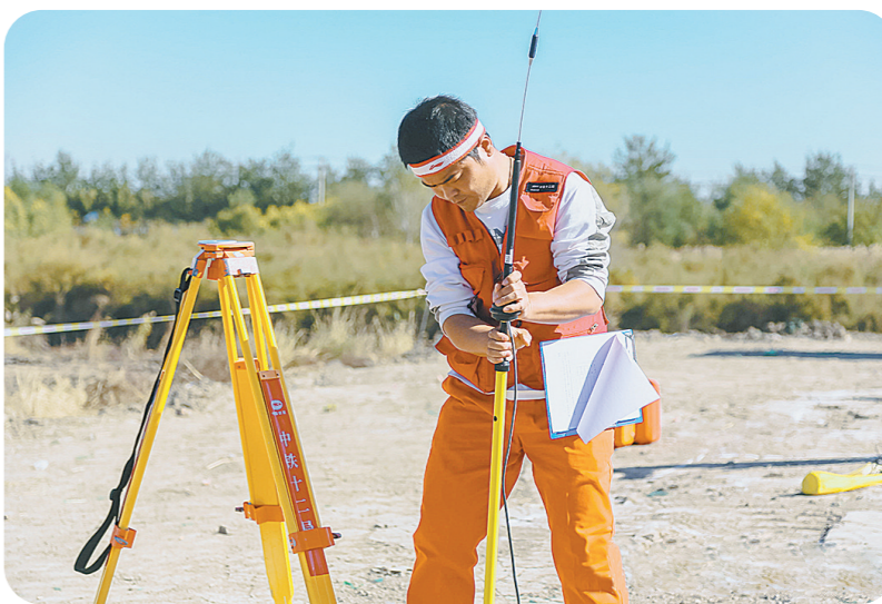
董长江在大寨中进行GPS-RTK基站架设。 中铁十二局 供图
