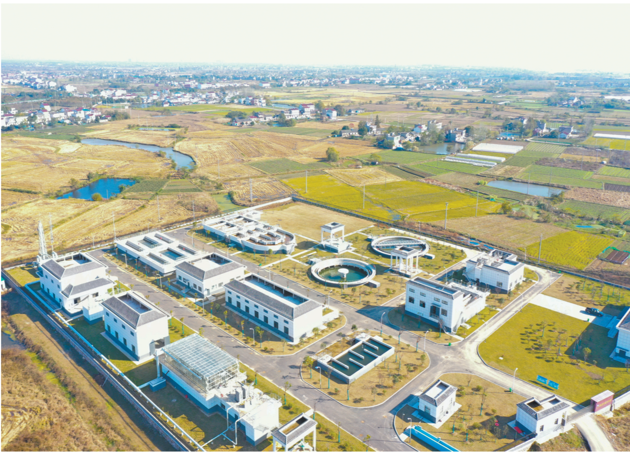
近日,安徽省马鞍山市和县经开区污水处理厂顺利通过马鞍山市的环保验收,预计于12月初正式投入运营。该工程是中国铁建参与“长江大保护”的重点项目,对完善和加强周边城区排污系统建设、保护长江水质具有重要作用。图为中铁十四局承建的污水处理厂。 王观生 摄
