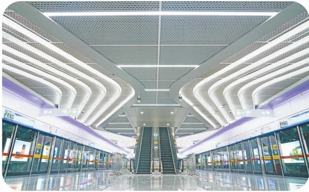
广州地铁18号线洗村站站台。 陈浩摄
