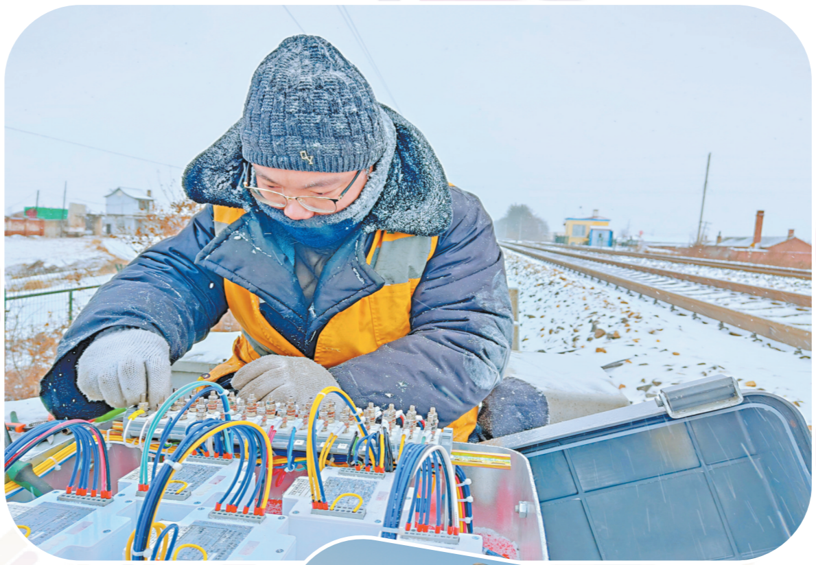
▲11月7日至8日,受强冷空气影响,黑龙江东北部地区出现暴雪降温极端天气。中铁二十三局电务公司绥佳线香兰站大修改造工程项目部组建多支清雪突击队清除冰雪,并做好对现场设备的维护。图为现场作业人员在风雪中整理箱盒配线。 王鹏摄
