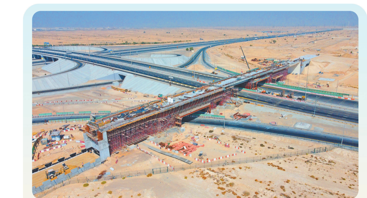
当地时间11月3日,中国土木顺利完成阿联酋铁路世博桥主体结构混凝土浇筑,成功架起当地新地标性建筑。世博桥为双绞线预应力箱梁结构,全长251.45米,共6跨,单跨最大跨度55米。该桥横跨世博高速,且周围通信电缆、埋地高压线、天然气管道等13处公共设施需迁改保护,受到迪拜政府有关部门重点关注。该桥主体工程完工对年底正线铺轨贯通具有重要意义。图为世博桥主体结构混凝土浇筑现场。 谢锋摄
