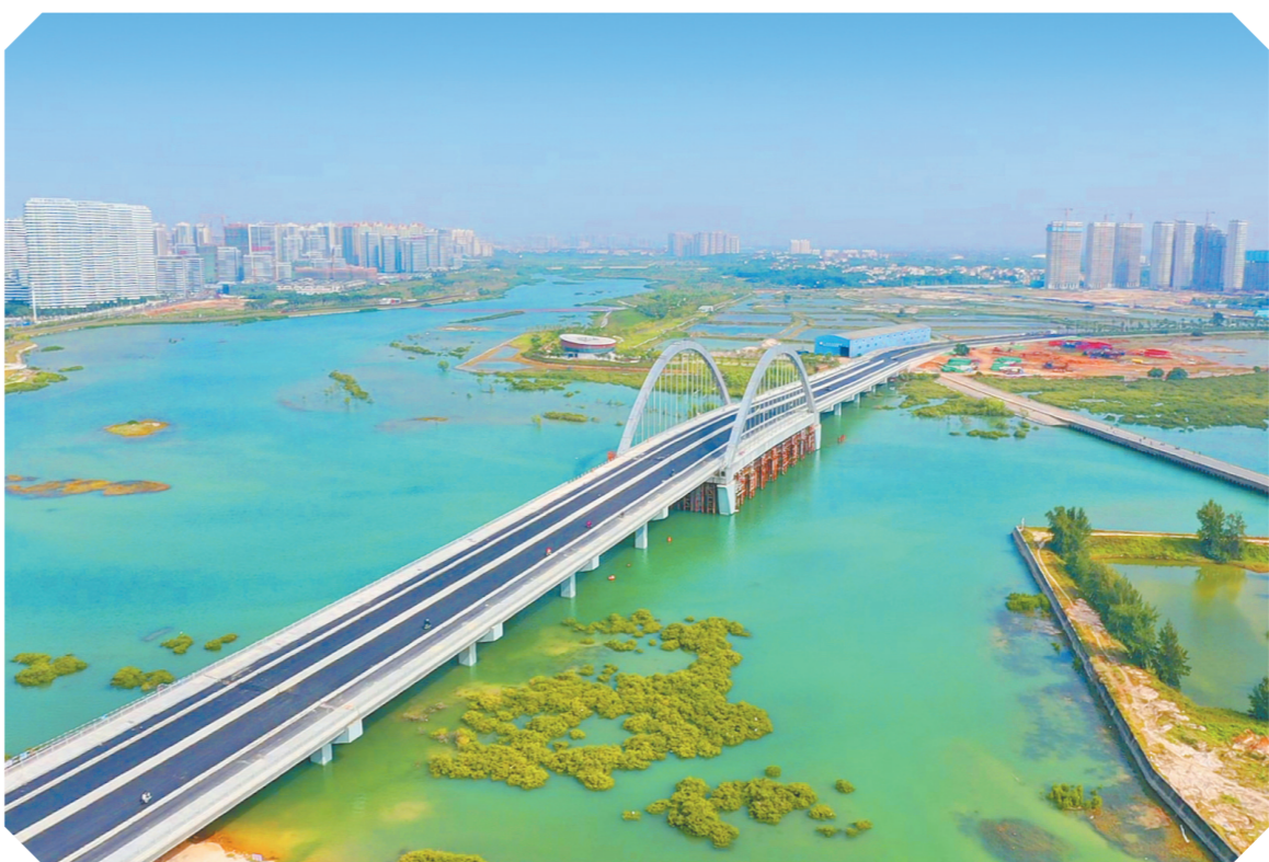
近日，由中铁十六局承建的广西北海市冯家江大桥主体工程完工，截至11月3日，项目附属工程已完成80%，桥面系、栏杆安装、人行道板安装和人行道砖铺设等已完工。该桥通车后，将实现本地区银滩三号路全部贯通，连通冯家江两侧时代金融城、金海湾红树林景区、五星级酒店群，进一步带动北海经济发展。图为北海市冯家江大桥。张军摄
