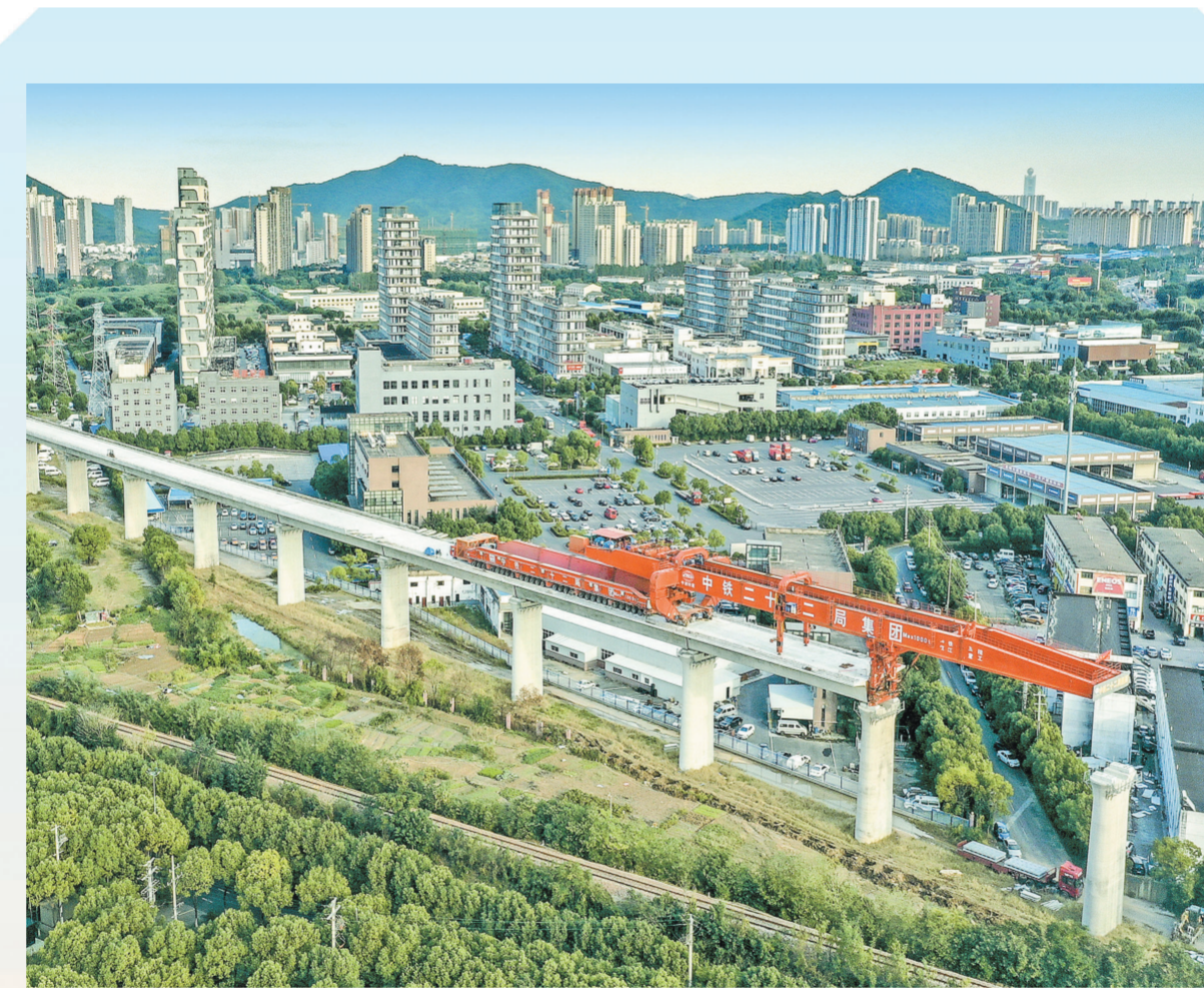
11月1日早9点,由中铁二十二局参建的南沿江城际铁路顺利完成首孔40米千吨箱梁跨既有铁路架梁施工,这是我国首条大规模采用40米千吨箱梁的高速铁路项目。为解决千吨级箱梁的运输和架设难题,该项目技术攻关团队在施工过程中采用先进的数控钢筋加工、智能自驱内膜、智能张拉压浆等最新智能设备、新工艺,同时在运输及架设过程中对穿隧式架桥机操控程序进行优化,为今后同类施工积累了宝贵经验。图为建设者正在进行空中架梁作业。
