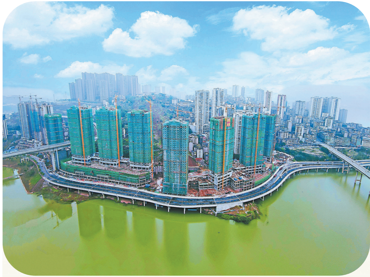
10月27日,由中铁二十三局承建的重庆在建体量最大装配式安置房项目——重庆忠县棚户区改造项目顺利封顶。该项目总面积达25.03万平方米,移交后,将有效改善重庆忠县危房困难群众的居住条件,更好地推动城市有机更新。图为封顶后的项目全景。刘婧懿摄
