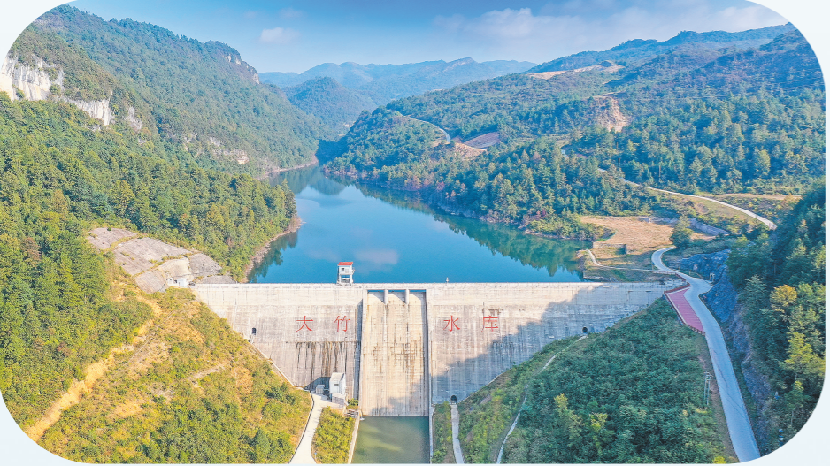
图为中铁二十局五公司承建的贵州龙里大竹芒水库。徐彬摄
