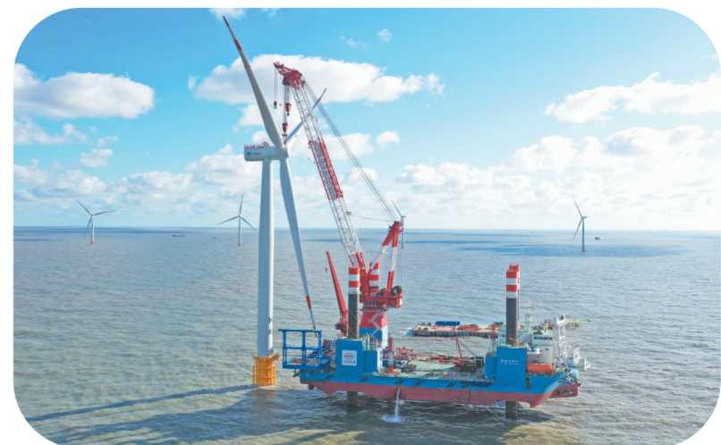
10月30日,由中国铁建港航局承建的启东海上风电H3标段最后一台风机顺利安装,标志着我国单体容量最大海上风电项目首个标段主体工程顺利完工。 于安 摄
