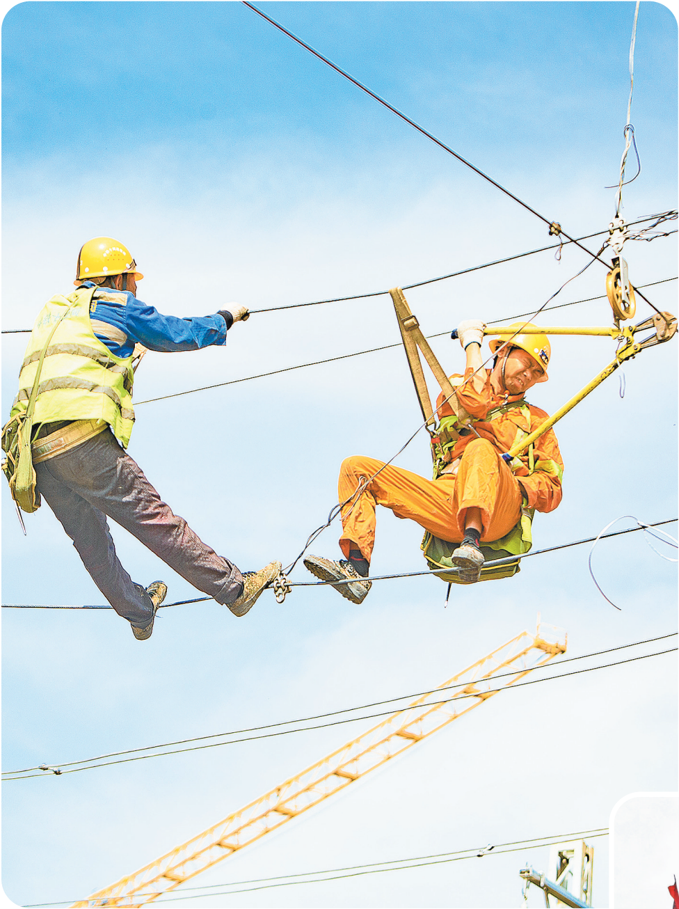
▲为迎接即将到来的第十四届全国运动会,从8月17日开始,中铁十四局电气化公司参建的西安站改项目开展全面安全大检查,严格管控所有人员进出,实行封闭管理,对施工人员进行现场安全培训,加强疫情防控和施工安全双防控,为办好十四运提供有力保障。图为工人正在进行铁路接触网导线换装作业。 杨 渊 摄
